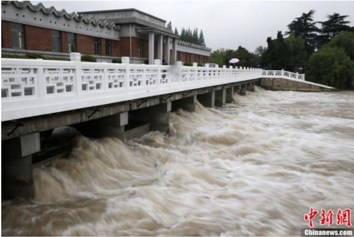
资料图：南水北调东线一期工程江苏省江都水利枢纽。中新社发 刘关关 摄
