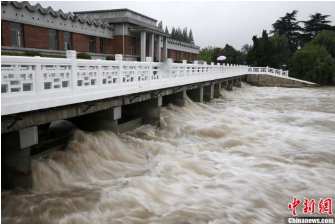
资料图：南水北调东线一期工程江苏省江都水利枢纽。中新社发 刘关关 摄
